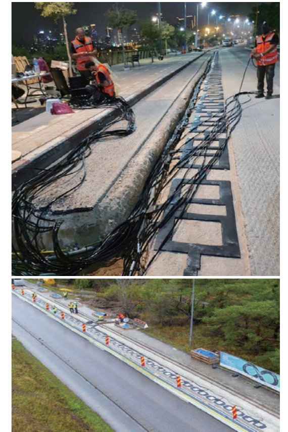
<그림 6> 무선충전도로 실제 시공 사례 6)
