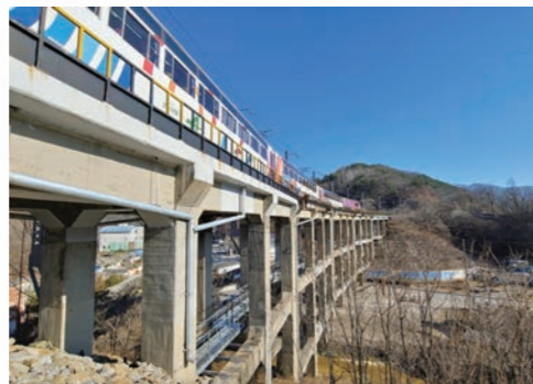
태백선 라멘교로 만든 조동철교 위를 사복음으로 향하는 형형색색의 무궁화호 관광열차가 지나가는 모습. 주변 풍경이 평화롭기만 하다. ©이영천
