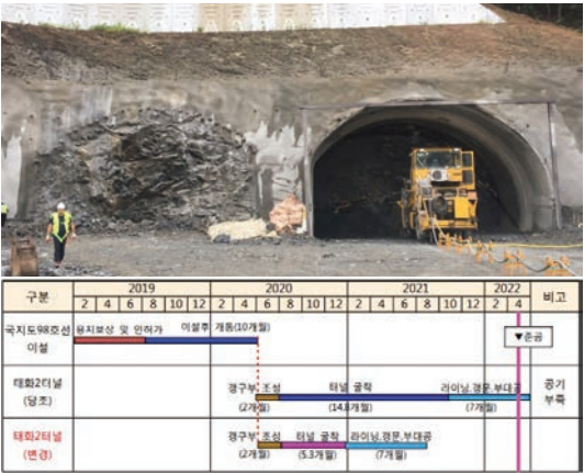
〈그림 9〉 태화2터널 근접병설터널 공법
