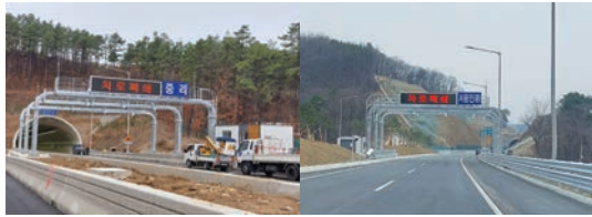
〈그림 4〉원톨링 설치 전경
