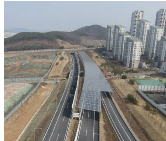
〈그림 6〉동탄2신도시 방음터널 전경
