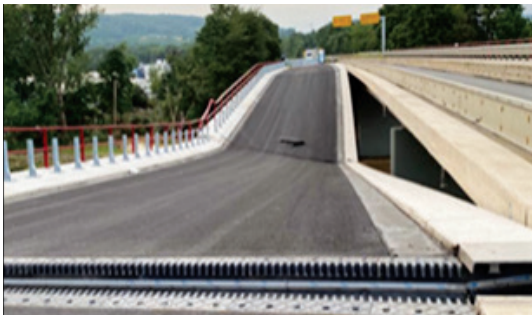
<그림 4> 교량 피해 사례 (독일 교량)
