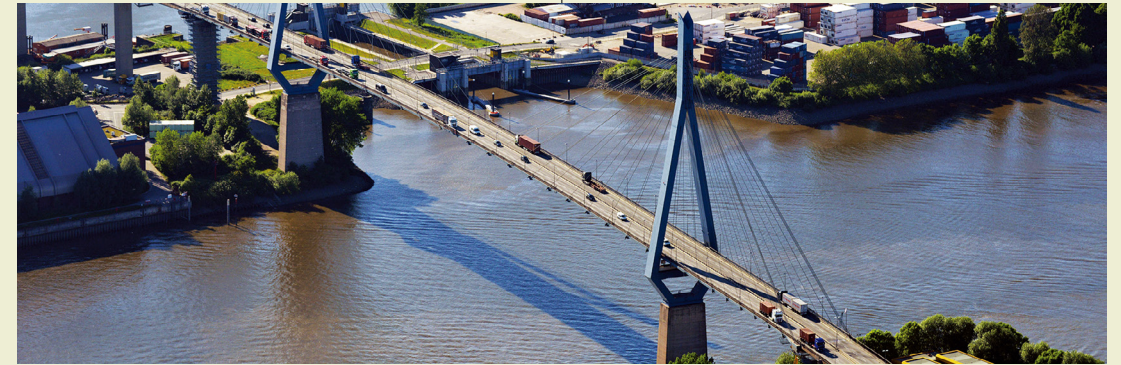
그림 3. Köhlbrand Bridge 전경 (출처: HPA AöR & MKP GmbH*)
