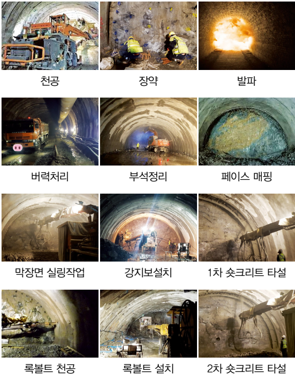
[그림 18] NATM 공법 시공순서
