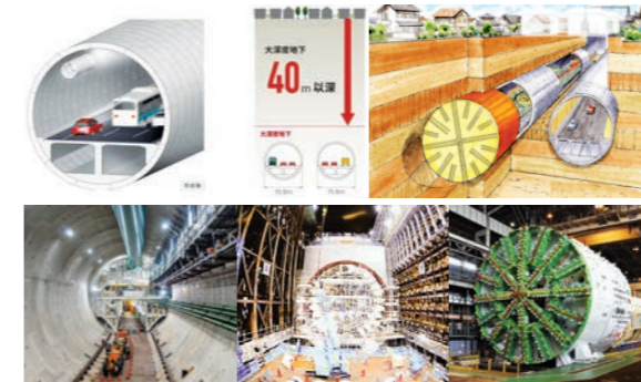
[그림 21] 대심도 지하도로(도쿄 외곽순환도로) - 쉴드 TBM 터널
