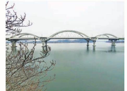
3경간 아치의 탄금대교. 가야금 소리와 유유히 흐르는 남한강 물결을 형상화하였다. ©이영천
