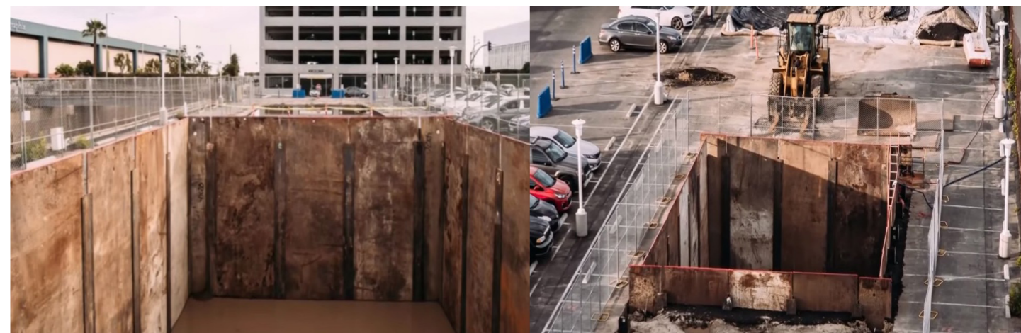
그림 9. 미국 LA(Los Angeles)의 보링(Boring) 건설현장
