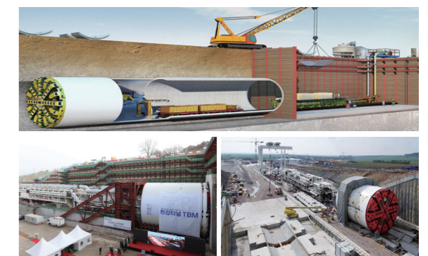
[그림 19] TBM 터널 시공 프로세스
