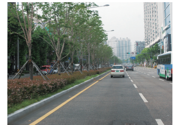
녹지중앙분리대, 부산시 구간
