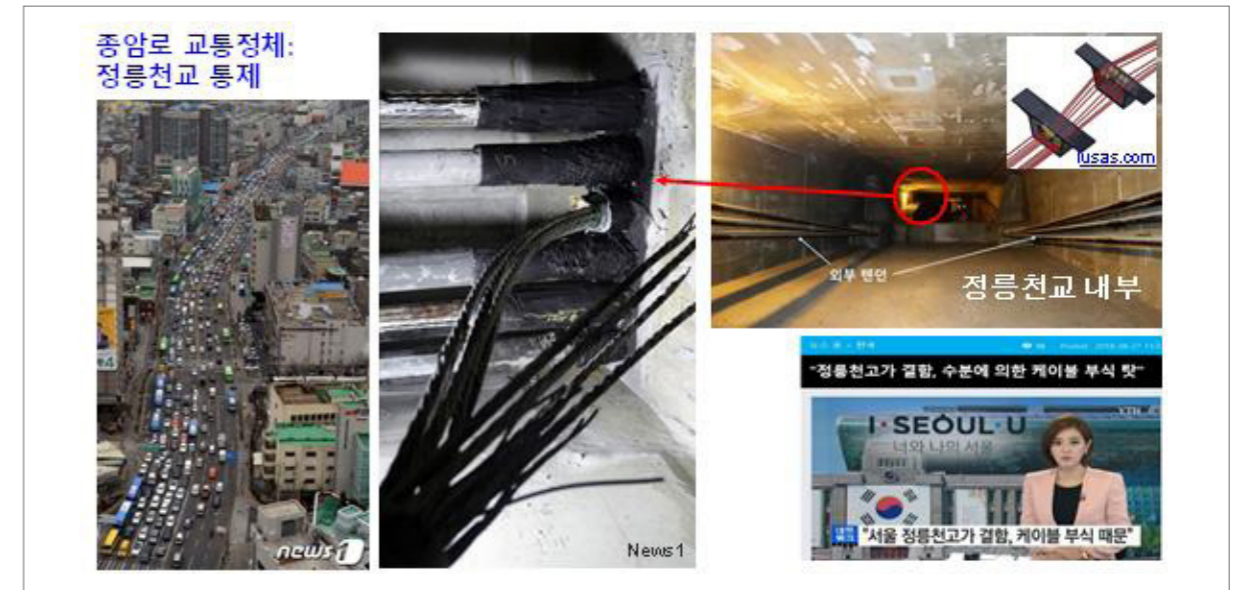
〈그림 1〉 정릉천교 외부텐던 부식사건 관련 사진들: 왼쪽부터 정릉천교가 교통체증으로 인한 교통체증, 외부텐던이 부식된 사진, 정릉천교가 내부에 배치된 외부텐던, 정릉천교가 부식사건 관련 보도
