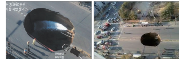
[그림 22] 인천 도시철도 NATM 터널 붕락 및 싱크홀 사고 (2012, 인천)
