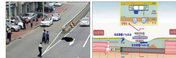
[그림 21] 서울시 지하철 TBM 터널 싱크홀 사고 (2014, 서울)
