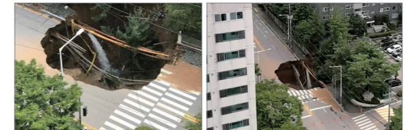
[그림 23] 별내선 지하철 NATM 터널 붕락 및 싱크홀 사고 (2020, 구리)
