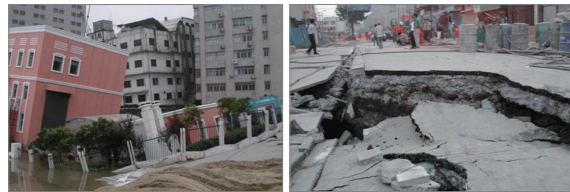
[그림 11] 상하이 메트로 TBM 터널 붕락사고(중국 상하이, 2003)
