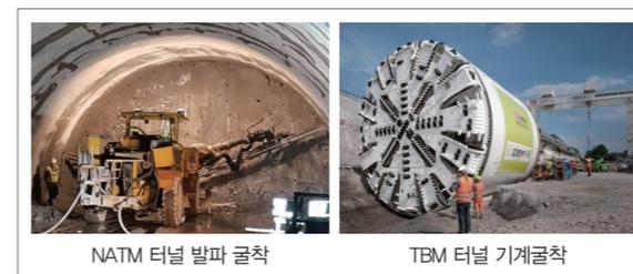
TBM(Tunnel Boring Machine) 공법은 TBM 기계장비를 이용하여 굴진하는 터널공법으로서 암반에 적용되는 그리퍼 TBM과 연약토사층에 적용되는 쉴드 TBM으로 구분된다. 기계공학의 발달과 함께 대단면의 TBM 장비가 개발되어 적용되고 있으며, NATM 공법에 비교하여 안전하다는 장점을 가지고 있어, 특히 리스크가 많은 해저터널에서의 적용성이 크다. 대표적인 해저터널로는 영불해협을 통과하는 유로 터널(연장 50.45km)이 있다.
