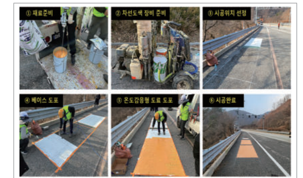
[그림 5] 시온도료 시공 과정
