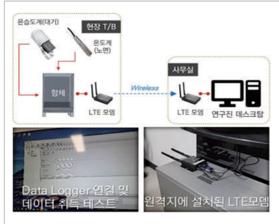
[그림 7] 계측데이터 취득 프로세스 및 설치 전경
