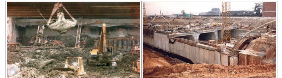
[그림 8] Advanced Tunnel Jacking
