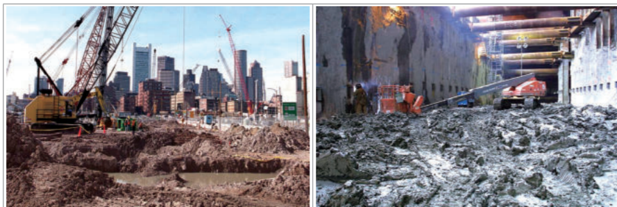
[그림 6] Slurry Wall Innovation
