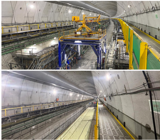
[그림 8] 콘크리트 슬래브 시공기술
