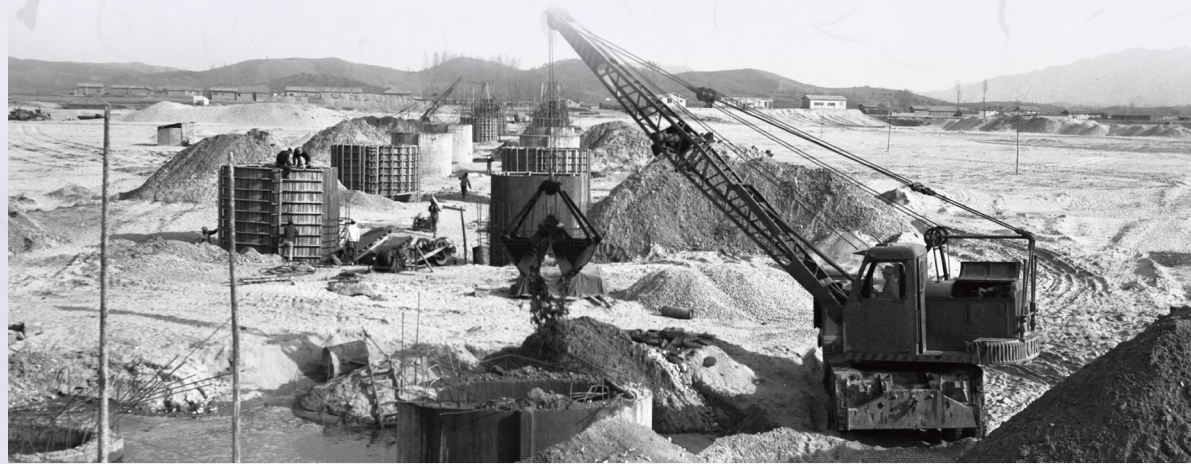
1966년 1월에 착공한 제3한강교(한남대교) 우물통기초 시공 모습. 한강은 모래 가득한 너른 백사장이고, 강남은 한가로운 시골이다. ©서울역사박물관
